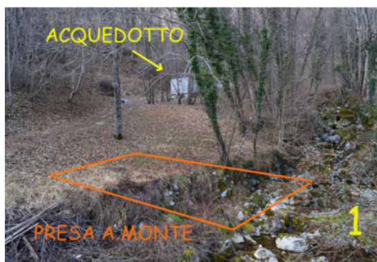
Foto 1 - Presa a monte
